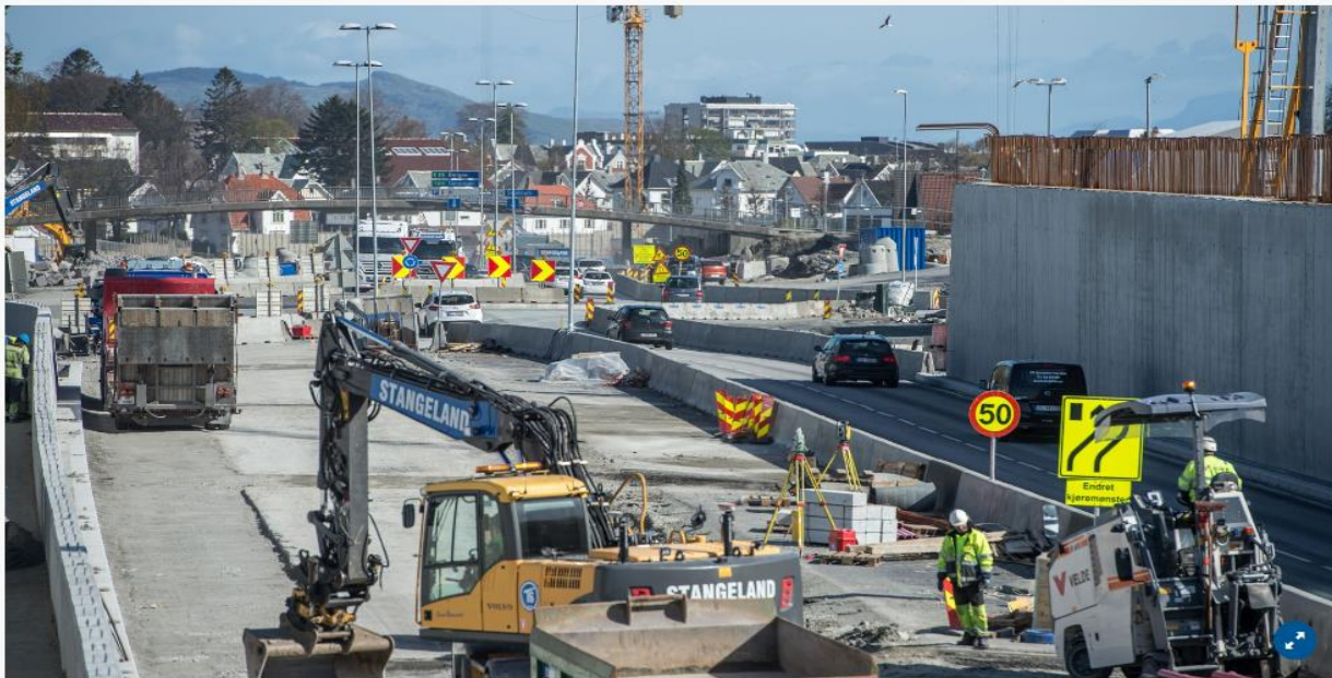
Bilde fra 2016. Arbeid i forbindelse med det store Ryfast-prosjektet. 📷 JARLE AASLAND
